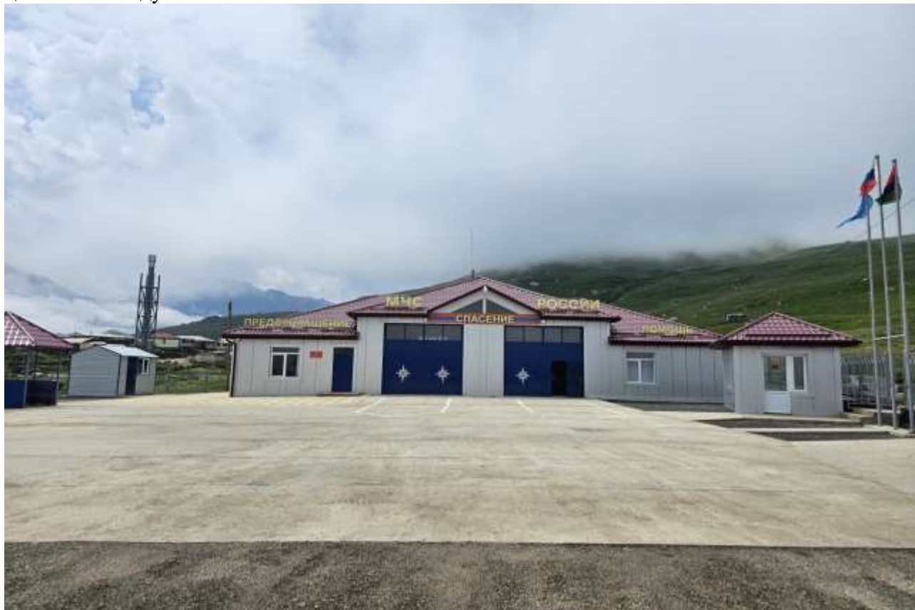
Пожарно-спасательная часть в с. Куруш Докузпаринского района.
